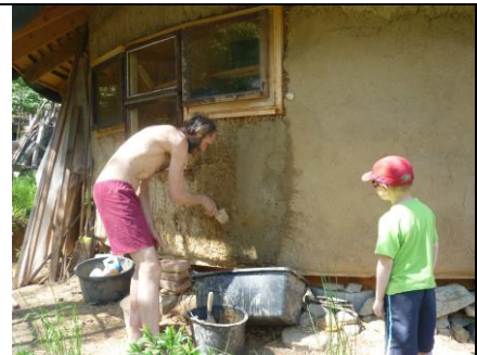
Petr omítá slaměnou jurtu, jeho elektromobil City EL se právě nabíjel z fotovoltaických panelů
